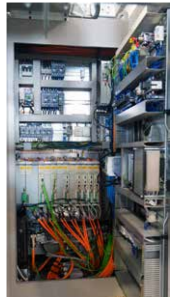
Techno Multiwall 配備了由 NUM 提供的 Flexium+ 68 數控系統以及馬達和驅動器
